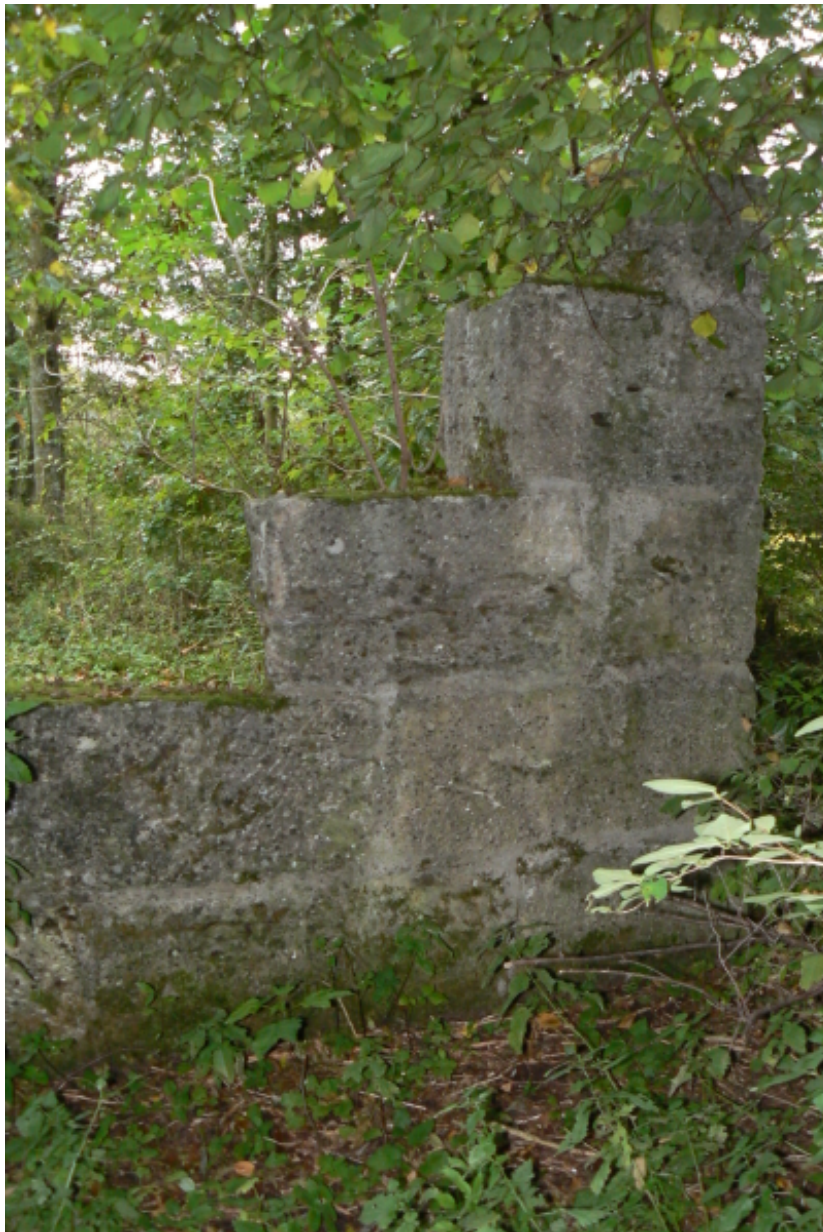
Aufmauerung an der Südostecke
