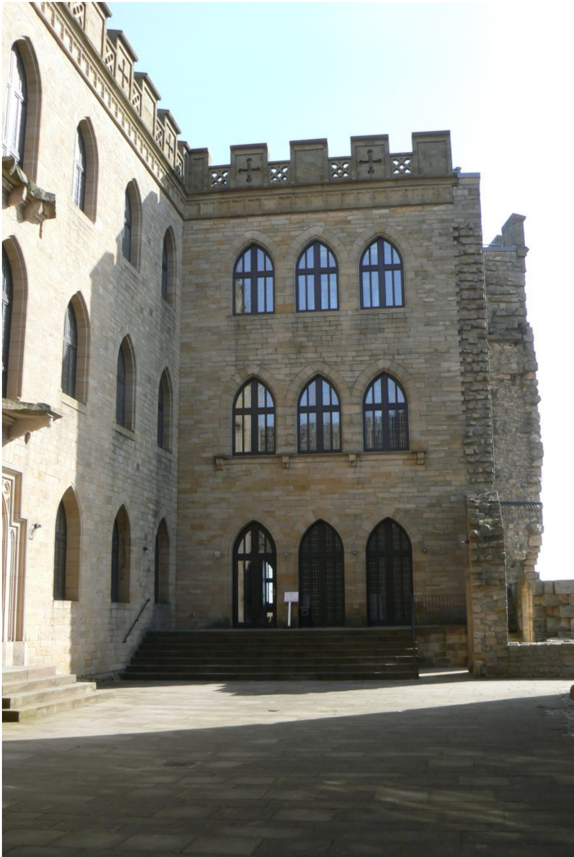
Westfassade des Palas zum Hof hin
