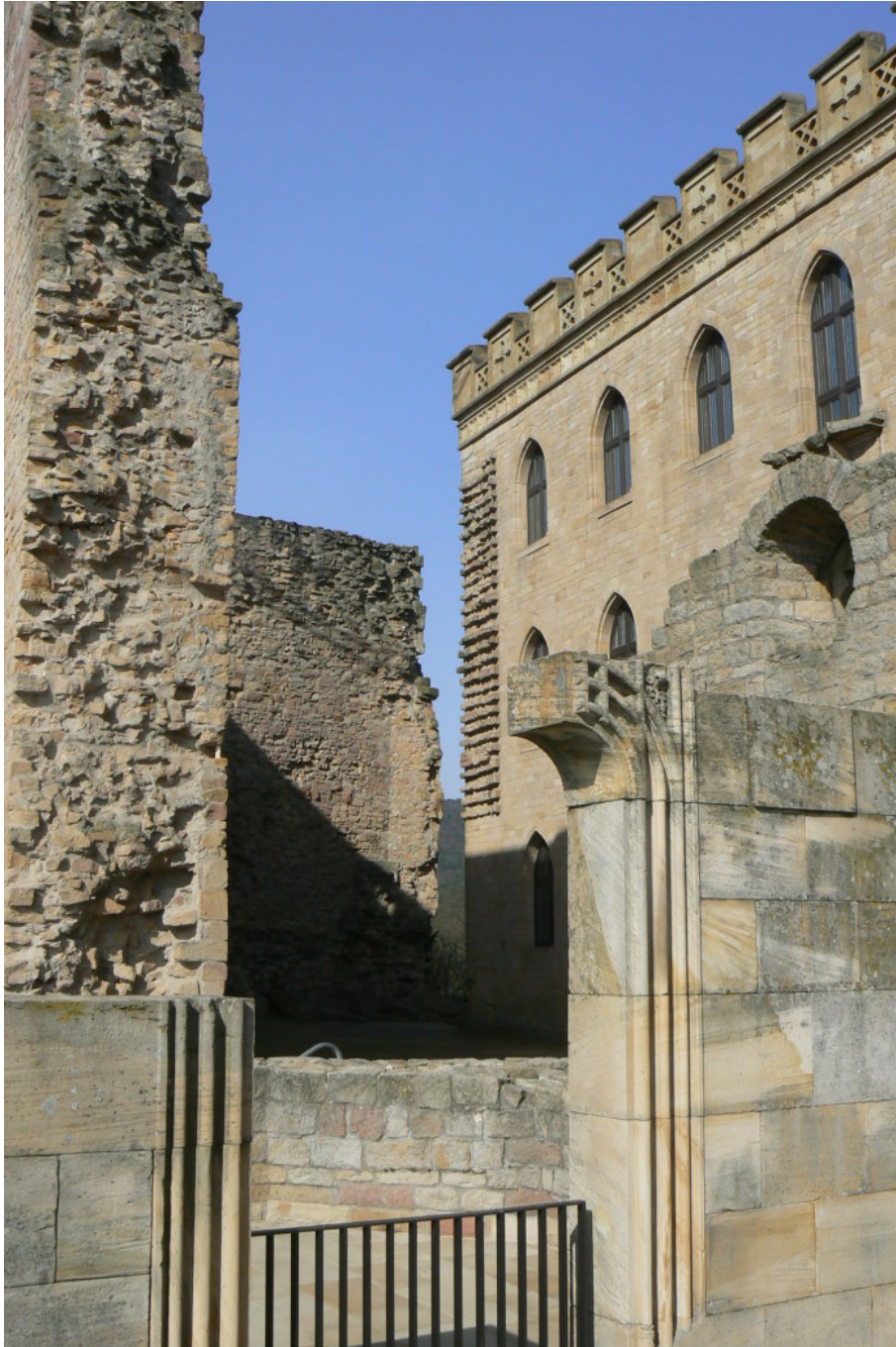
Unvollendeter „Speisesaalbau“ aus dem 19. Jahrhundert im Vordergrund, dahinter die Südfassade des Palas und der „Hohe Mantel“ (links)
