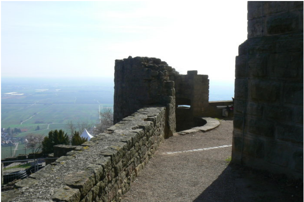
Bastion mit Blick in die Rheinebene nach Osten
