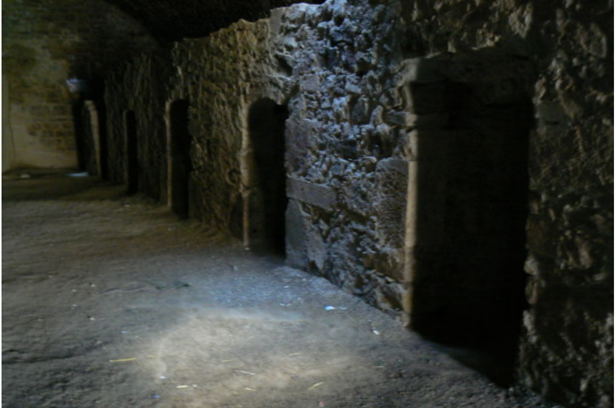
Zellen im Kellergewölbe
