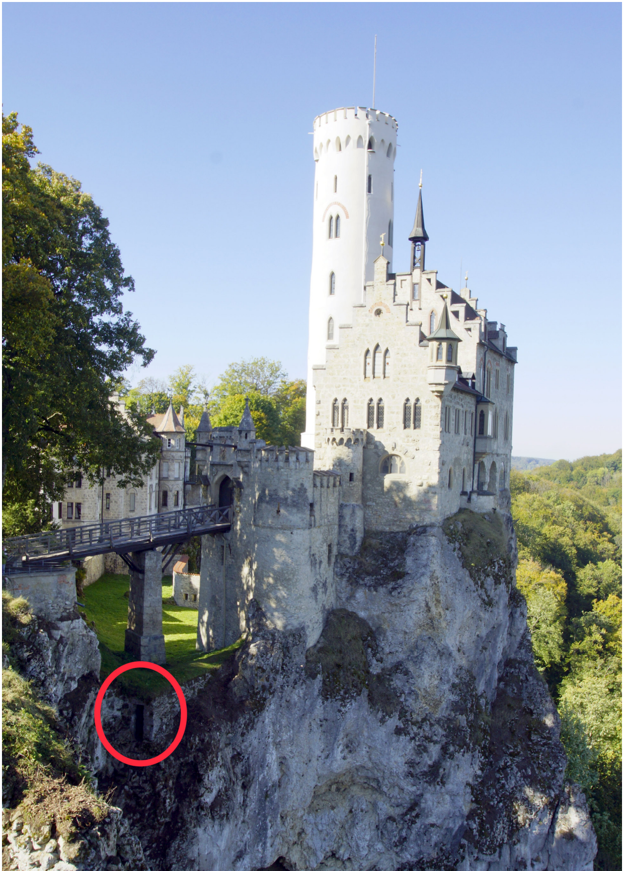
Südseite (roter Kreis zeigt den Ausgang der Fluchtpforte)
