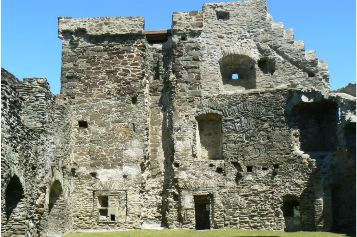
Nordseite des ehemaligen Palas
