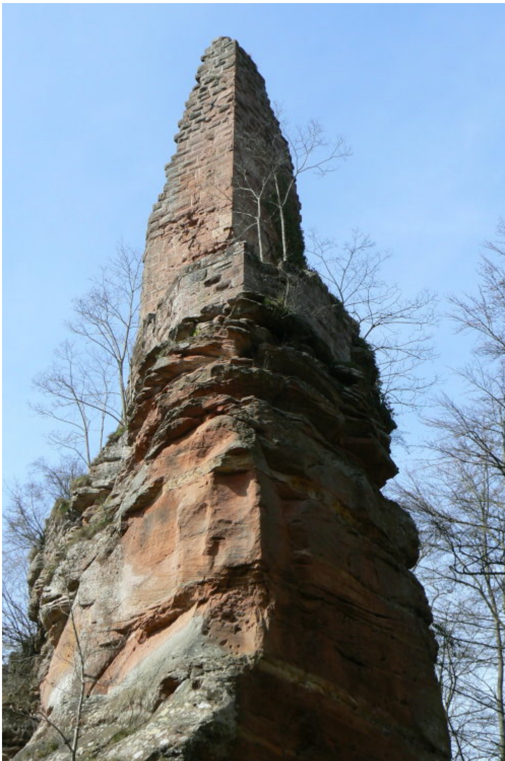
Schildmauerartiger Bergfriedrest auf der Ostseite der Alt-Wasigenstein
