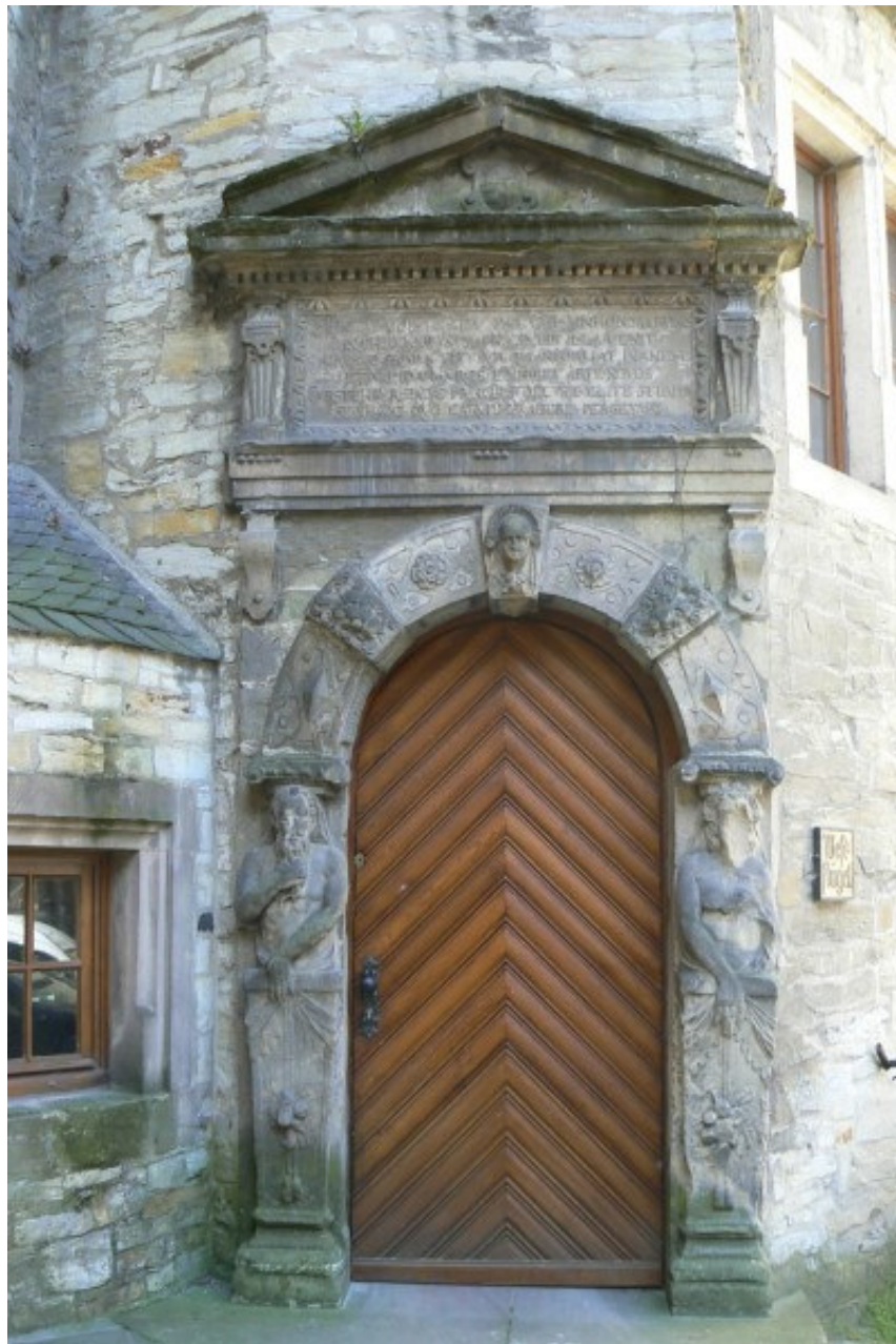
Treppenturm zwischen Süd- und Westflügel
