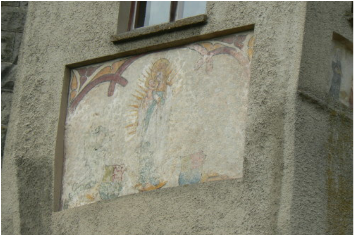
Außenwand der Kapelle
