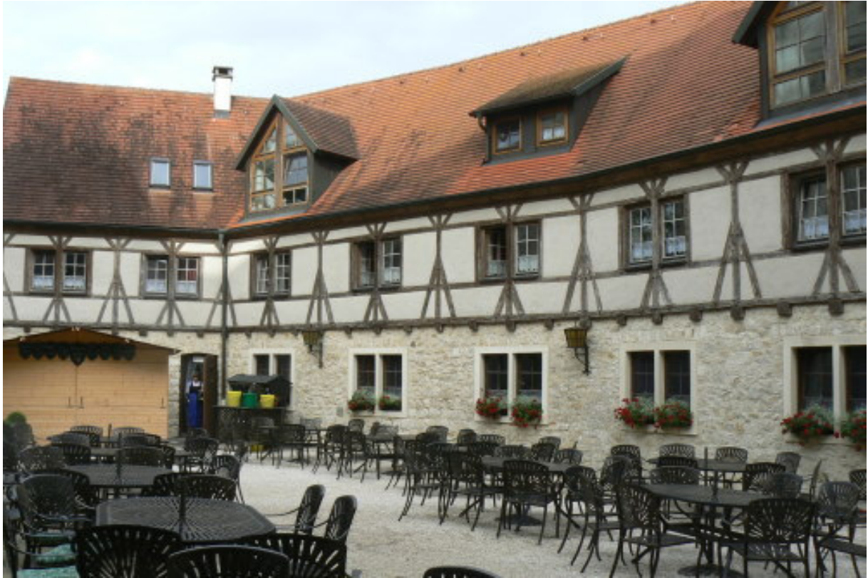
Hof mit Nordgebäude
