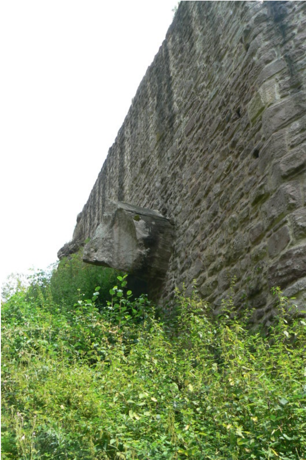
Fels in der Südmauer der Kernburg
